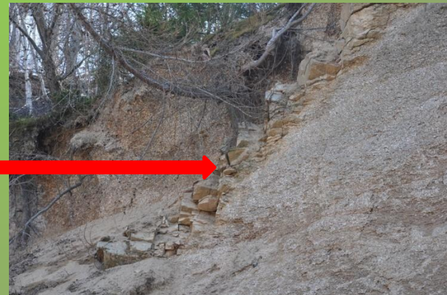
fot.5 Żyła aplitu w zwietrzelinie granitowej
